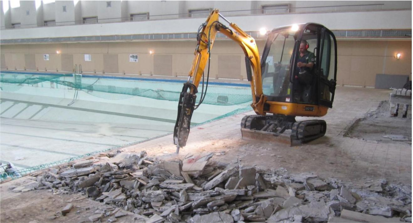
*Bagger meißeln die Fliesen von den Beckenumgängen ab (oben), die Hallendecke ist entfernt, die Lüftungen liegen frei (links) und die denkmalgeschützten Startblöcke sind gesichert (unten).*
